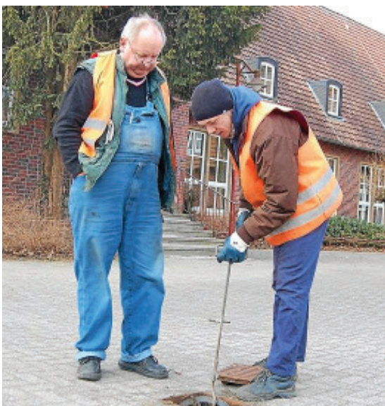
Bei der Arbeit: Der Strafgefangene Matthias K. reinigt einen Gully vor der Dreingauhalle in Drensteinfurt. Sein Arbeitgeber Ludger Hürländer zeigt sich, dass die Arbeiten fachgerecht ausgeführt werden.
